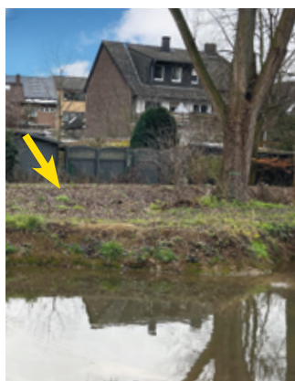
Hochwasserschutzwall am Neffelbach
