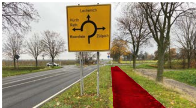
Der Fahrradweg zwischen Nörvenich und Pingsheim wird saniert.
