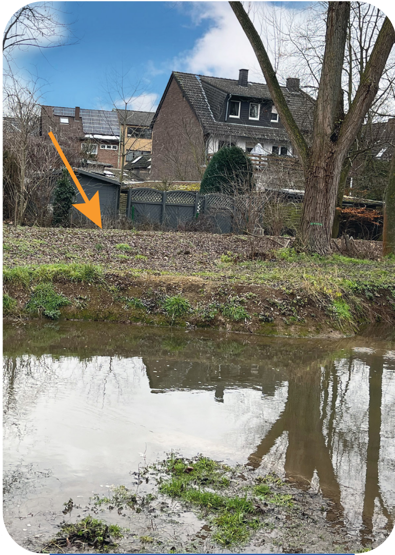
Hochwasserschutzwall am Neffelbach
