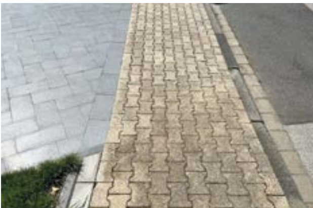
UNZULÄSSIGE AUSFÜHRUNG: Fördert Überstau auf der Fahrbahn.
