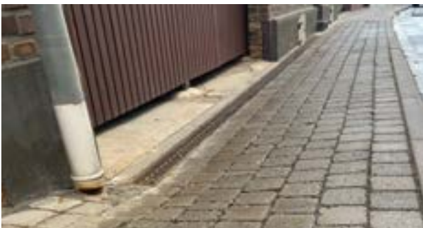
UNZULÄSSIGE AUSFÜHRUNG: Fördert Überstau auf der Fahrbahn.
